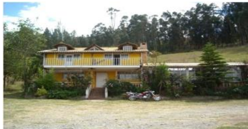
Figura 3.2 Fotografía de la entrada principal a la casa familiar (Andrade, 2015)
