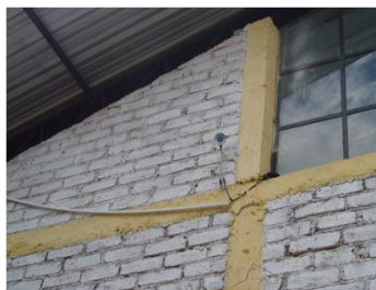
Figura: Cámara analógica CA1 colocada para la vigilancia del parqueadero y la entrada principal al complejo
