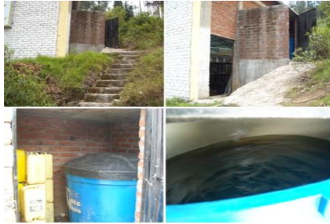
Figura 3.5 Entrada posterior al complejo y cuarto de almacenamiento de DIESEL (Andrade, 2015)
