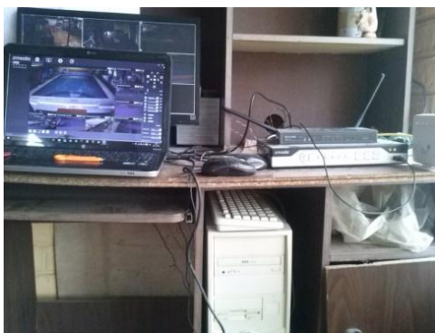
Figura: se presenta la central de mando del sistema de vigilancia
