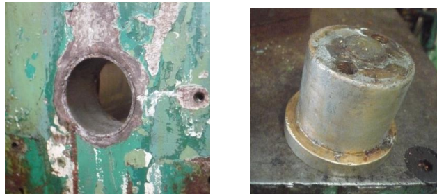
Gráfico 3.93: Desmontaje del bulón. Fuente: Los Autores
