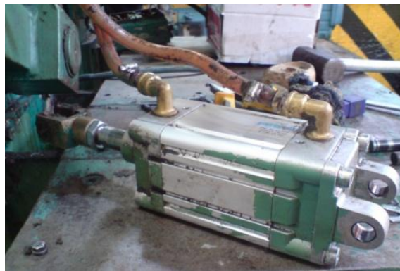
Gráfico 3.67: Desmontaje del cilindro neumático de doble efecto Fuente: Los Autores
