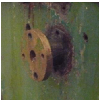
Gráfico 3.80: desmontaje de la espiga de bronce
