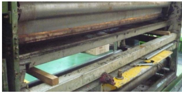
Gráfico 3.79: Colocación de soportes para extraer la bandeja. Fuente: Los Autores
