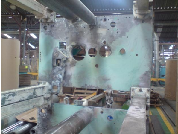
Gráfico 3.169: Reparación de las imperfecciones. Fuente: Los Autores
