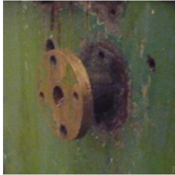
Gráfico 3.80: desmontaje de la espiga de bronce Fuente: Los Autores
