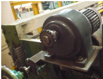
Gráfico 3.55: Desmontaje del motor reductor Fuente: Los Autores
