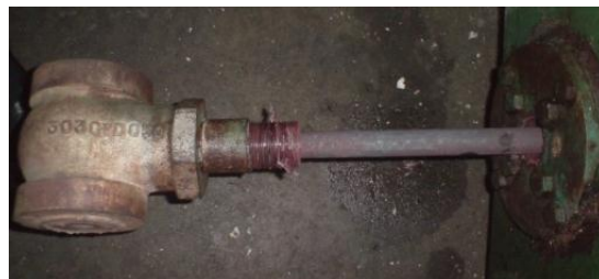
Gráfico 3.158: Desmontaje del sistema de ingreso de vapor. Fuente: Los Autores
