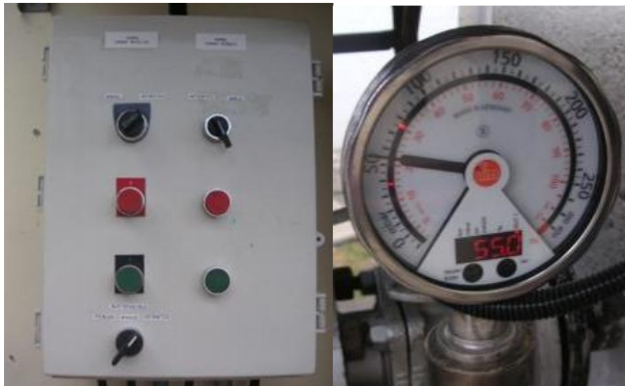
Anexo 15 Tablero de control, Presóstato
