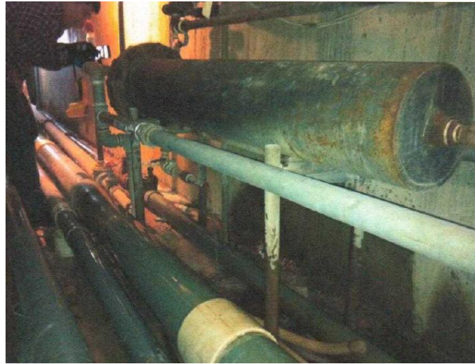
Figura 5. Instrumentos de medición del intercambiador de calor de la piscina recreativa en mal estado Fuente: (Quito Tenis y Golf Club, 2016)
