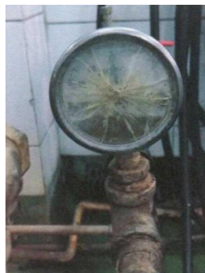
Figura 6. Trampas de vapor en mal estado y manómetro roto Fuente: (Quito Tenis y Golf Club, 2016)
