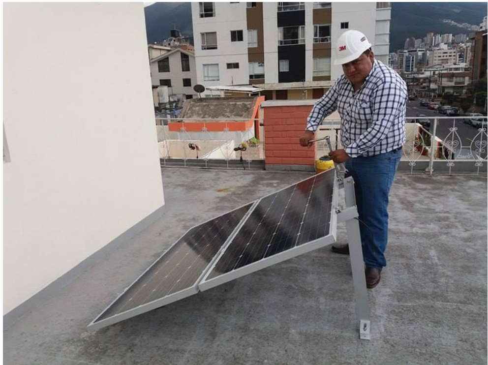
Figura 46. Montaje de paneles sobre la estructura
