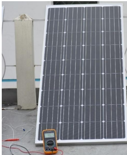
Figura 44. Medición de generación de paneles solares
