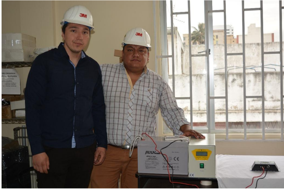
Figura 49. Verificación del voltaje requerido para alimentar el sistema
