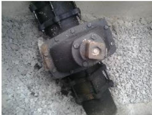
**Figura 21.** Válvula de compuerta en el lugar instalado.
