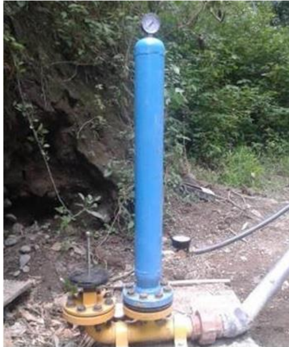
Figura 38. Instalación del ariete hidráulico con sus respectivas modificaciones. Elaborado por: (Pilco & Sandoval, 2016)
