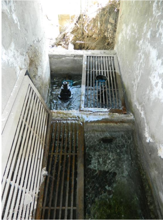
Figura 30. Tanque de almacenamiento donde se represará el agua Elaborado por: (Pilco & Sandoval, 2016)
