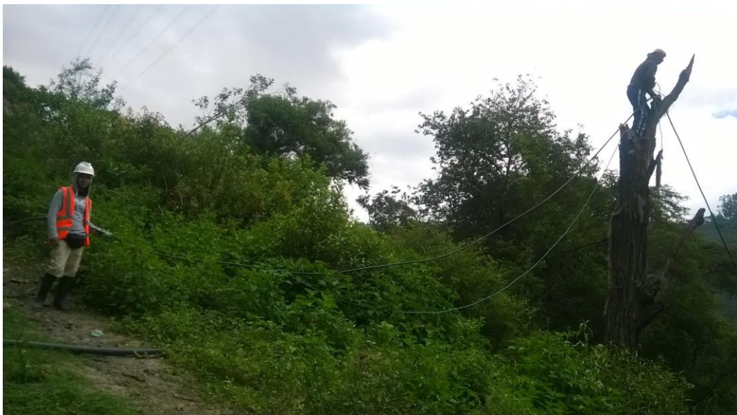
Figura 33. Instalación de la tubería de descarga Elaborado por: (Pilco & Sandoval, 2016)
