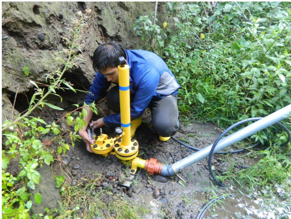
Figura 31. Colocación del ariete hidráulico en la nueva ubicación Elaborado por: (Pilco & Sandoval, 2016)
