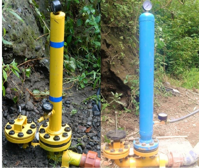
Figura 28. Instalación del ariete hidráulico con sus nuevos componentes. Elaborado por: (Pilco & Sandoval, 2016)
