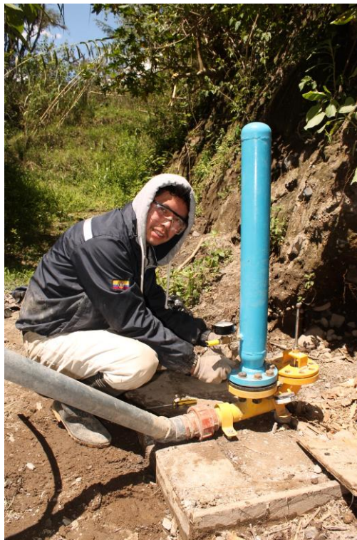
Figura 37. Instalación de la bomba con sus nuevos componentes Elaborado por: (Pilco & Sandoval, 2016)
