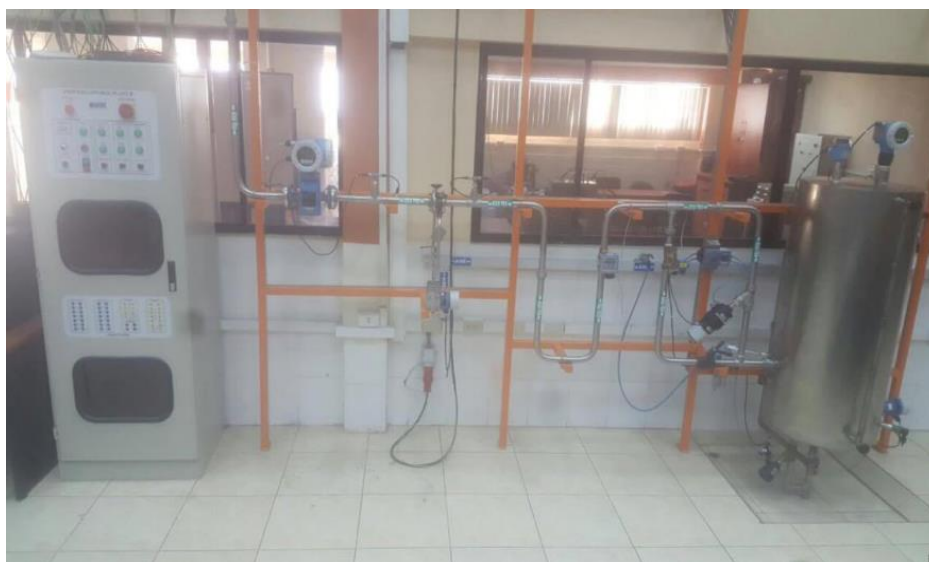
Figura 41 Planta B del laboratorio de control y automatización totalmente integrado de la Universidad Politécnica Salesiana
