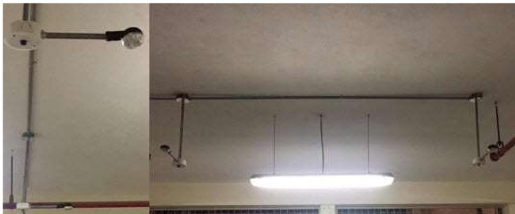
**Figura 29:** *Cajas reflectoras Instaladas en el parqueadero del bloque B*
