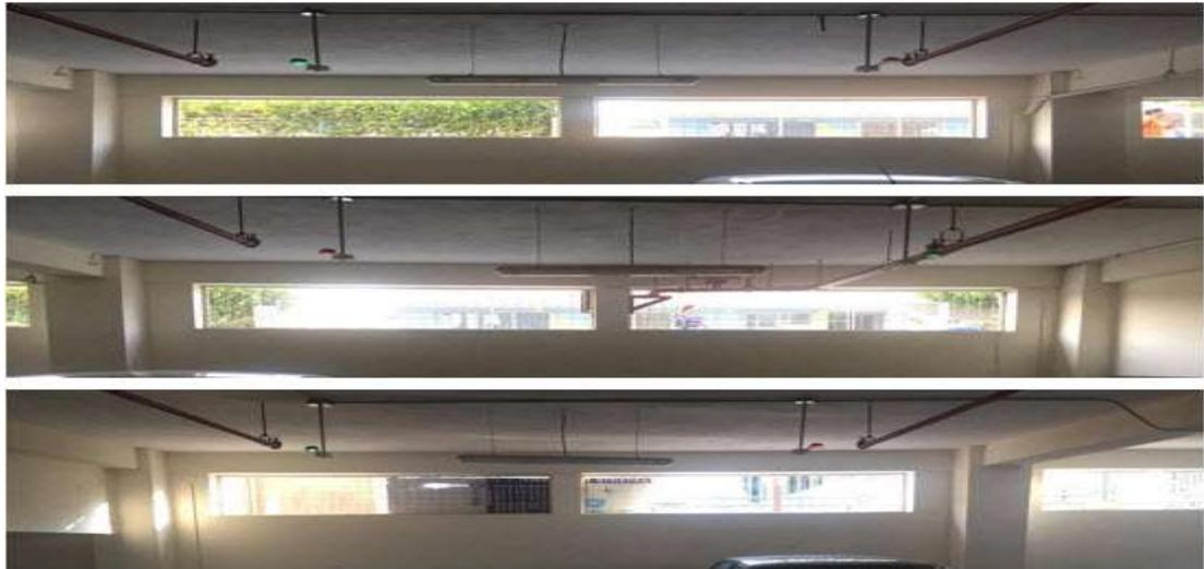
**Figura 36:** *Cajas reflectoras Instaladas en el parqueadero del bloque B
