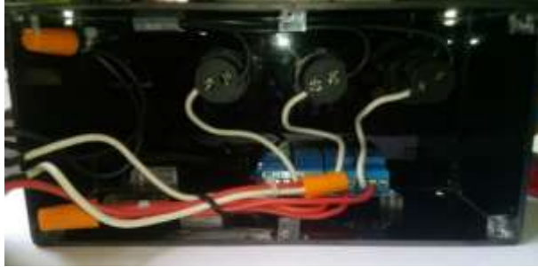
Vista interna, conexiones.
