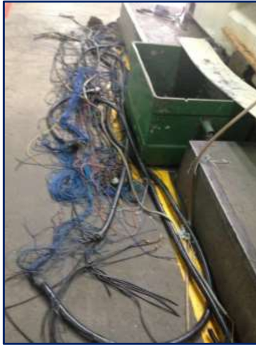
Figura 39. Retiro del cableado viejo.
