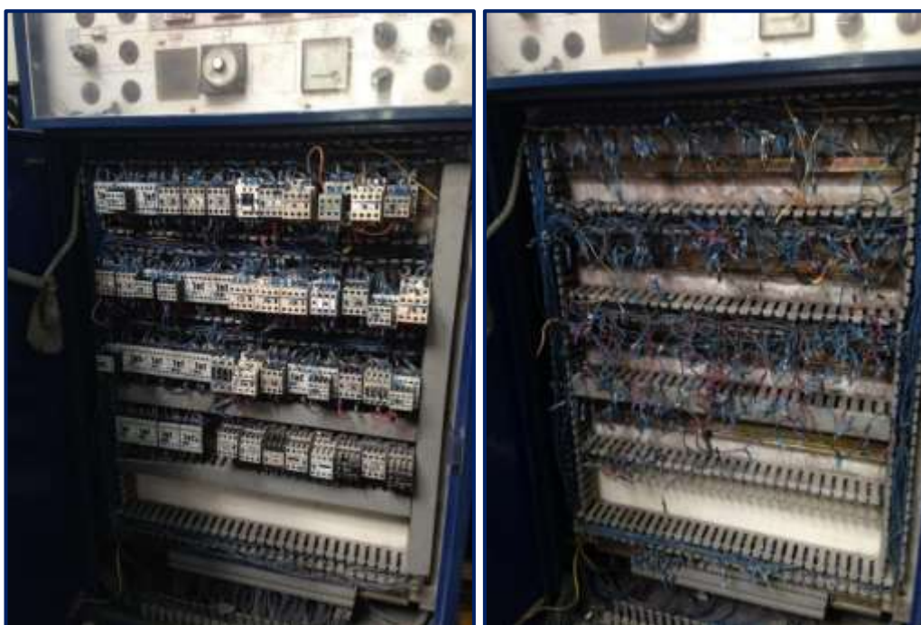
Figura 38. Tablero de control viejo y sus elementos de control (izq). Tablero de control viejo con elementos de control desconectados y retirados (der).
