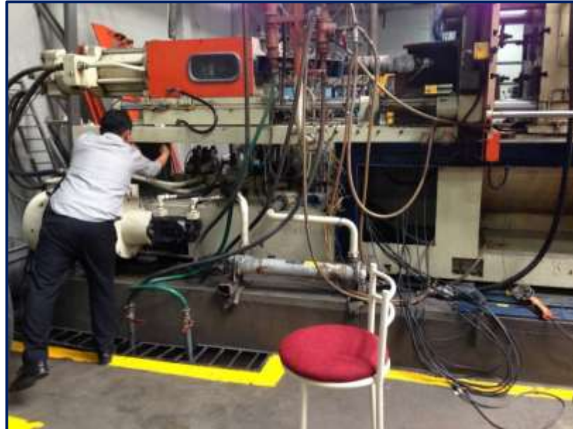
Figura 41. Cableado nuevo de la máquina inyectora MIR.
