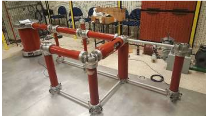
FIGURA 76: ARMADO DE ELEMENTOS DE CIRCUITO GENERADOR DE IMPULSO.
