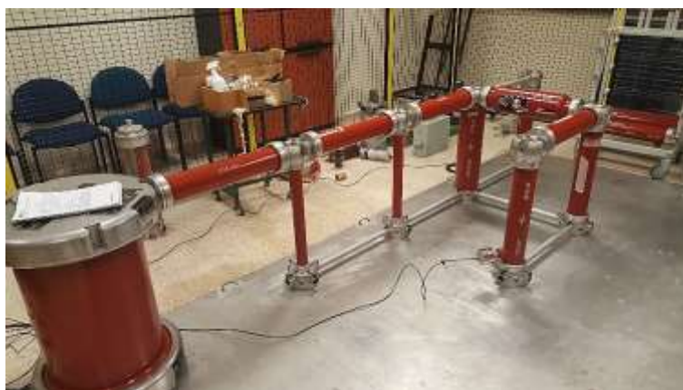
FIGURA 75: ARMADO DE CIRCUITO GENERADOR DE IMPULSO.
