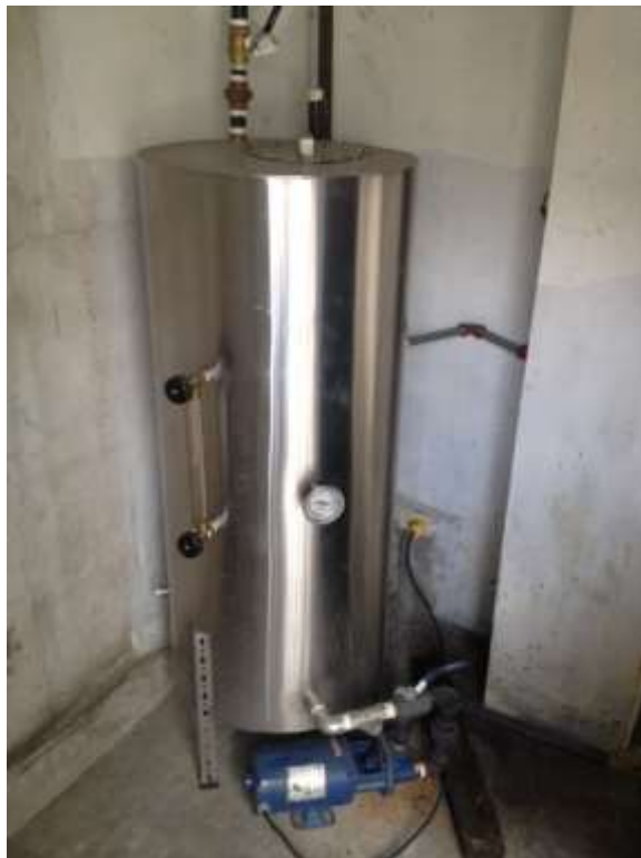
Figura 39. Tanque de suministro de agua para el caldero
