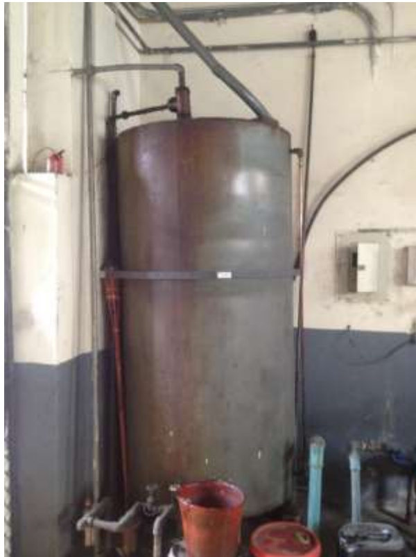
Figura 40. Tanque de suministro de combustible para el caldero
