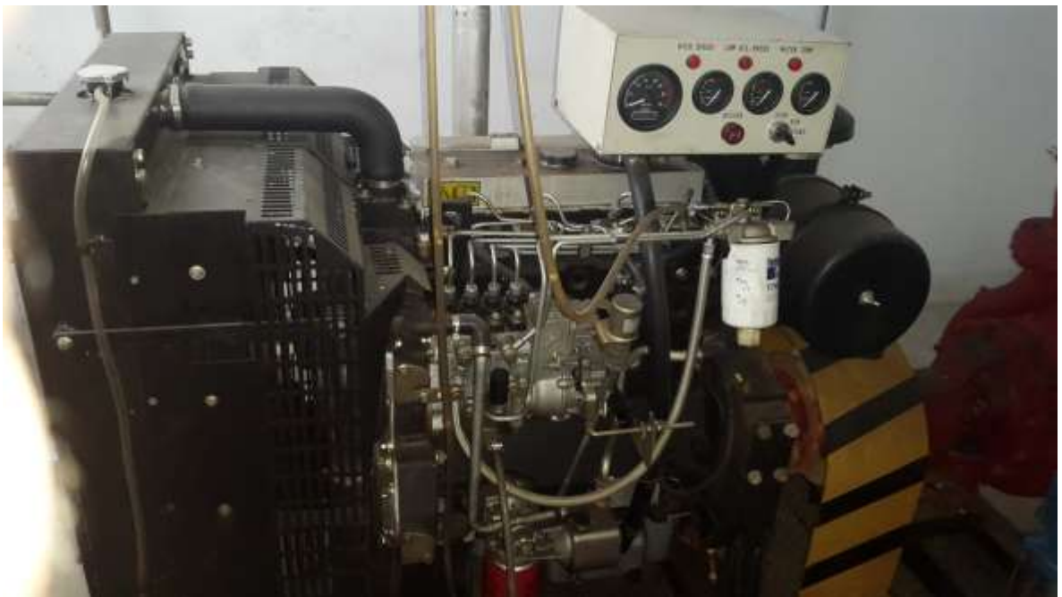
Figura 22. Sistema Motriz de Combustión Interna Bomba Bloque B
