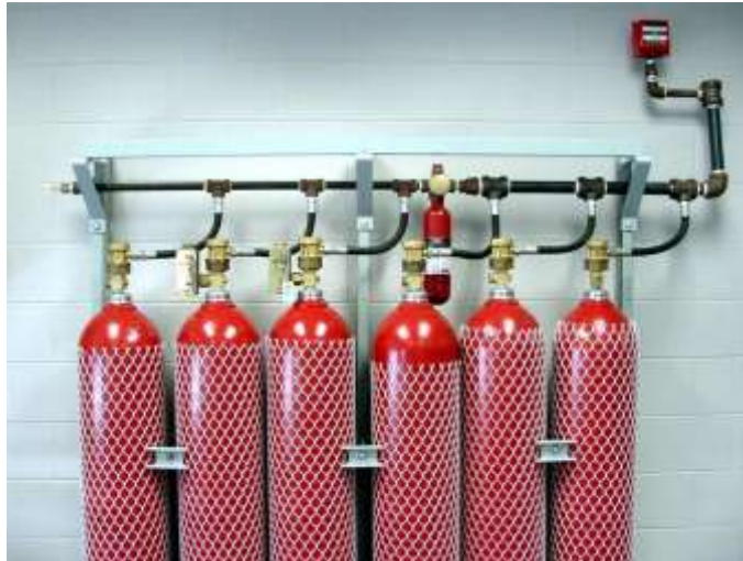
Figura 12. Sistema fijo de banco de CO2
