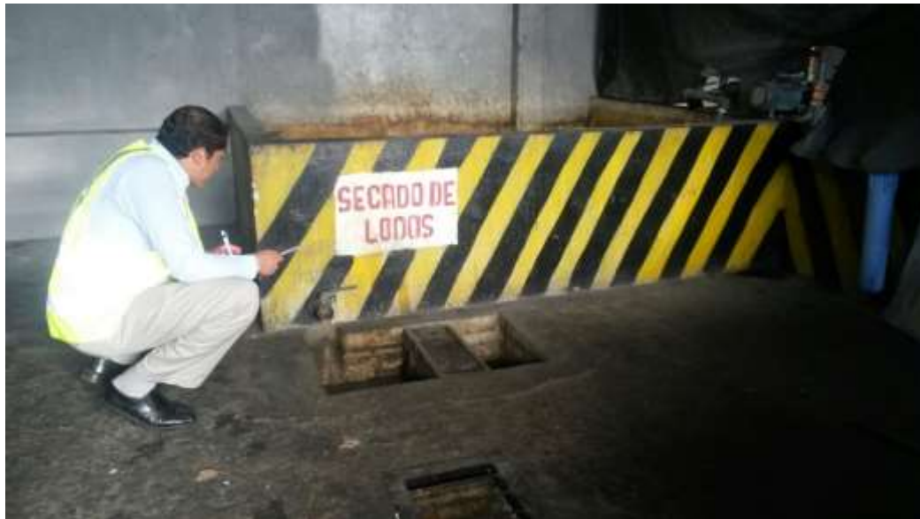
Almacenamiento de lodos previo a su disposición final
