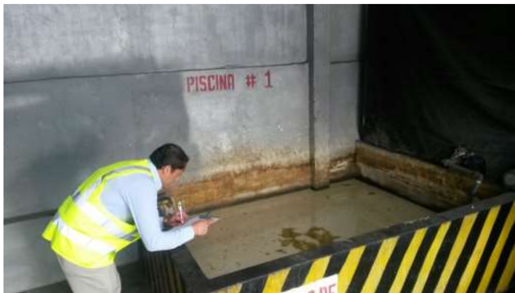
Piscina N° 1 agua de clarificación
