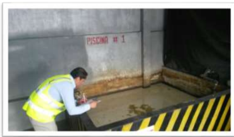
Piscina N° 1 de Homogenización, Sedimentación y Clarificación
