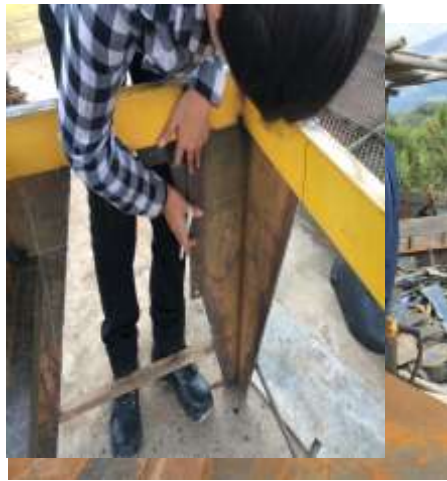
Paso 6. Soldar las patas dobladas a 90° con el marco de la mesa.
