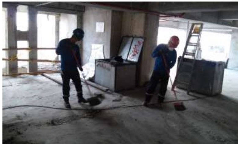
Figura 6: Limpieza del sitio de trabajo al final de la jornada. Ubicación: Edificio Aerocity junto al Aeropuerto Fecha: 04-ene-2016 Fuente: el autor.
