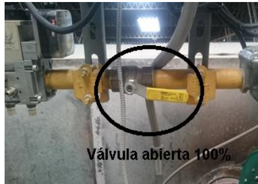
Figura 11: Válvula para paso GLP.
