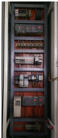
Figura 3: Tablero Eléctrico Secadero Moldes 3 Fuente: EDESA S.A.
