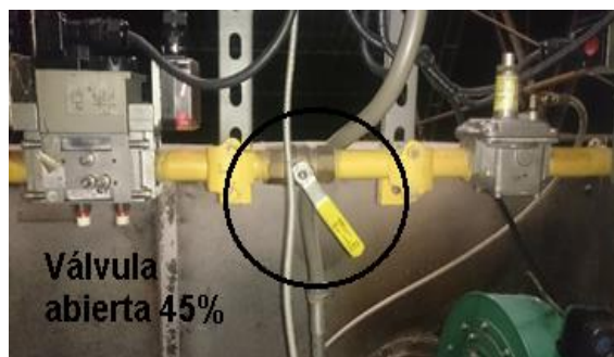
Figura 12: Válvula genera presión para paso de GNL.
