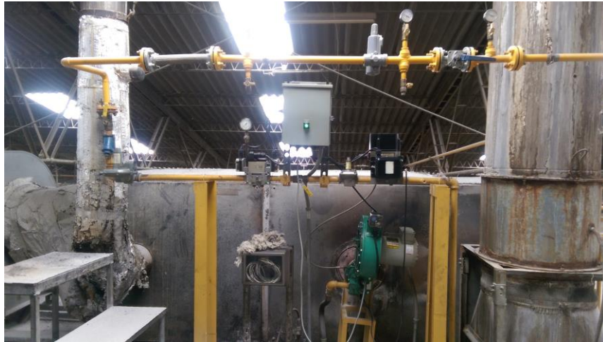
Figura 10: Quemador Secadero Moldes.
