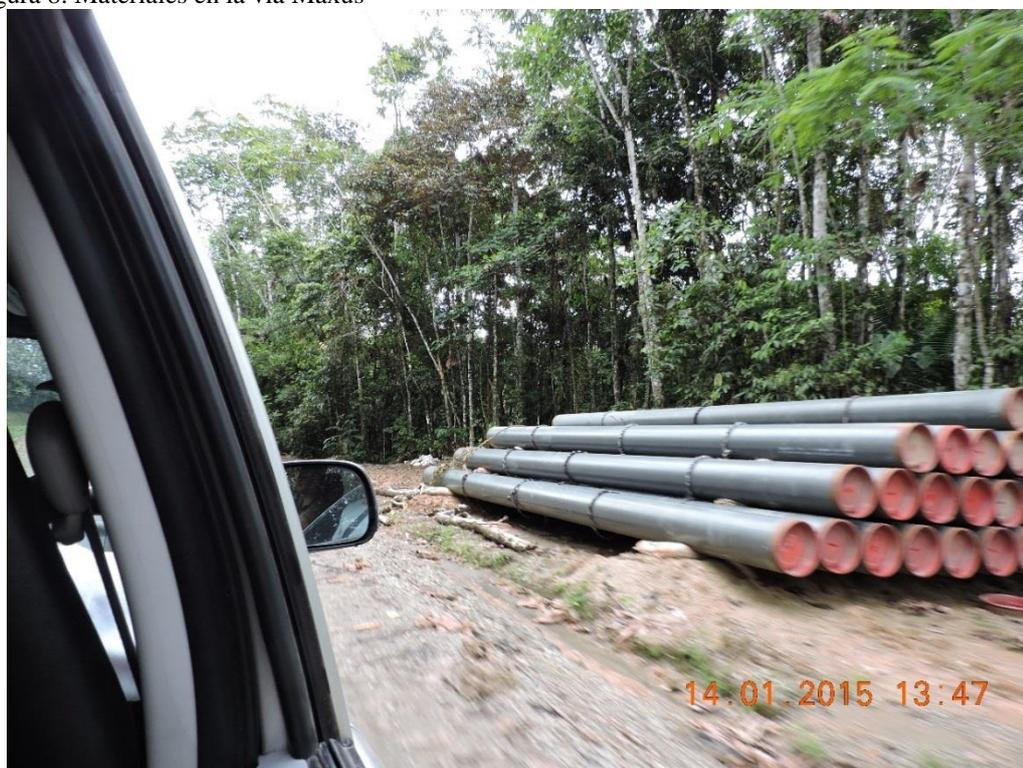
Materiales destinados para la reparación de ductos ubicados a los costados de la vía.
