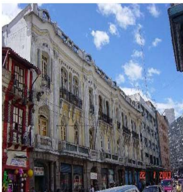
Uno de los edificios en donde funcionó el Ministerio de Economía en décadas pasadas, ubicado en la calle Guayaquil (sector de San Blas, junto al antiguo cine Alambra)
