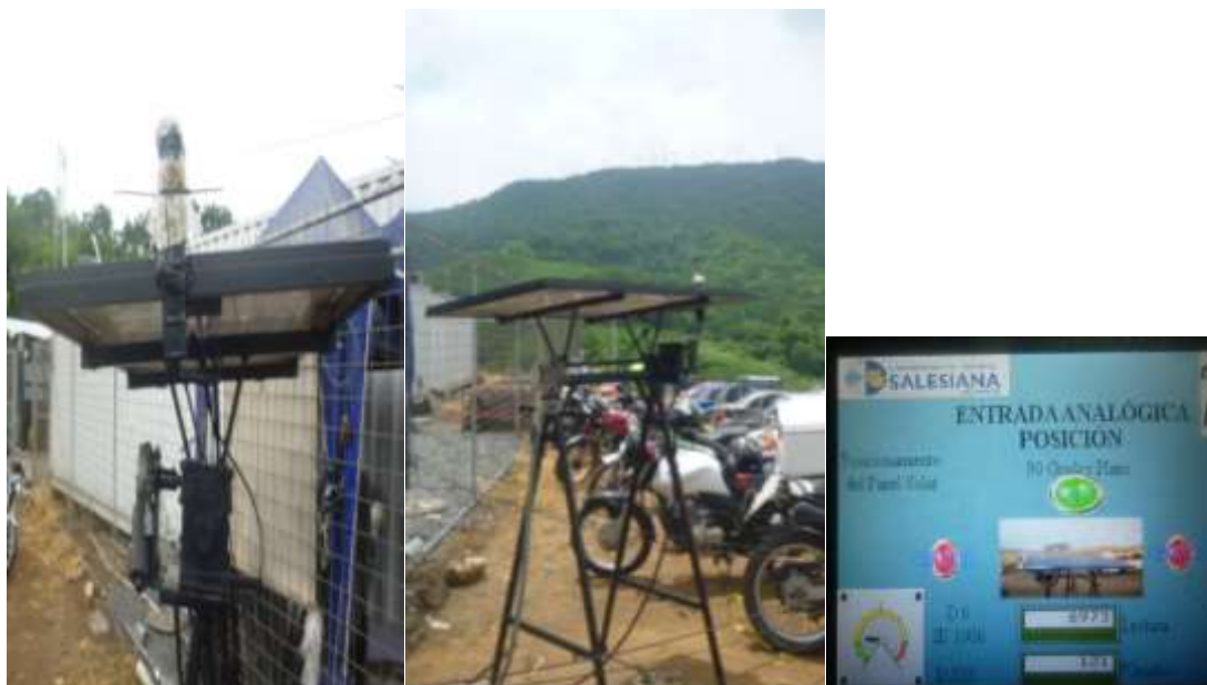
Figura 70. Panel solar en estado horizontal (11:20 am – 13:15 pm)
