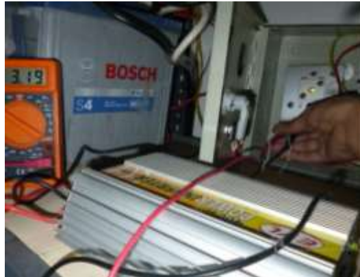
Figura 72. Prueba de voltaje del panel solar
