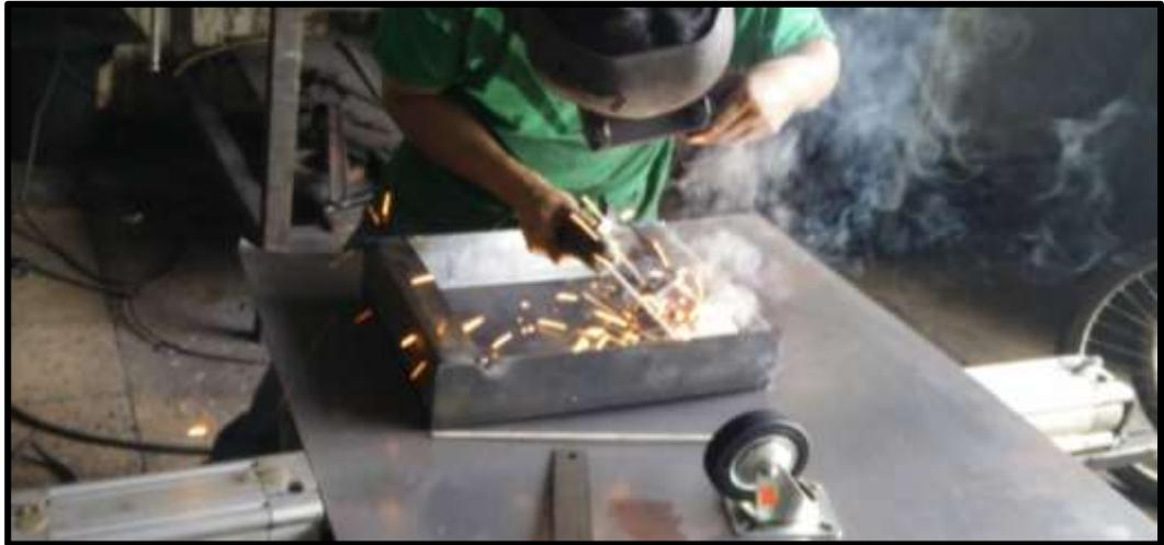
*Figura 51.* Construcción de la base de la mesa del generador
