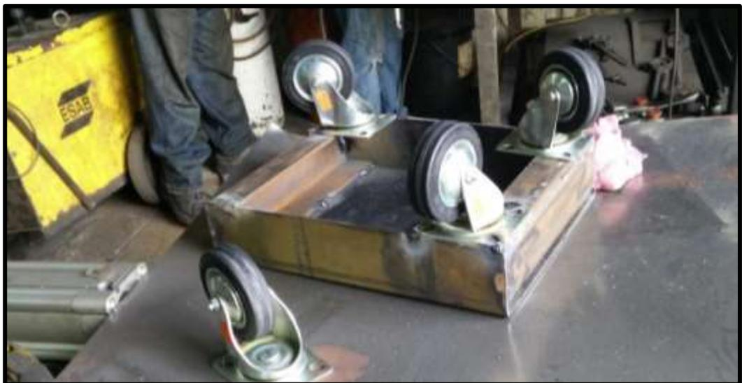
*Figura 52.* Soldada de las garruchas a la base de la mesa del generador
