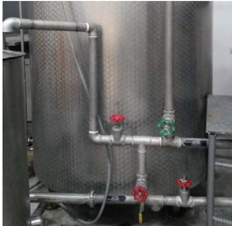
Figura 6. Sistema manual de control para cocción,
