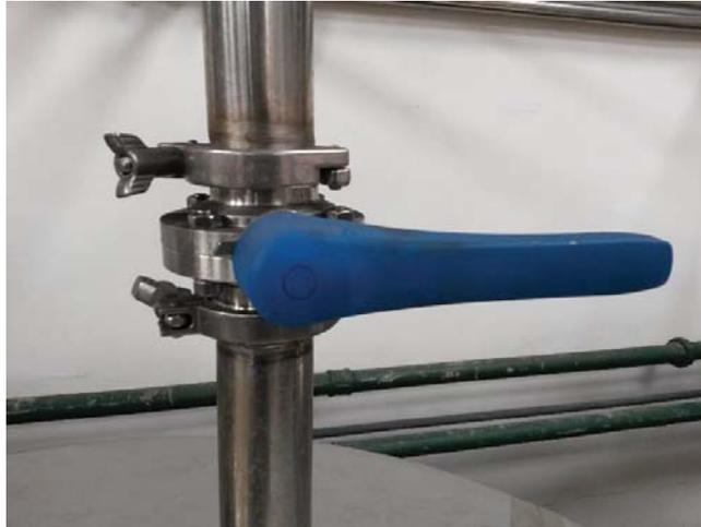
Figura 17. Válvula manual para control de caudal.
