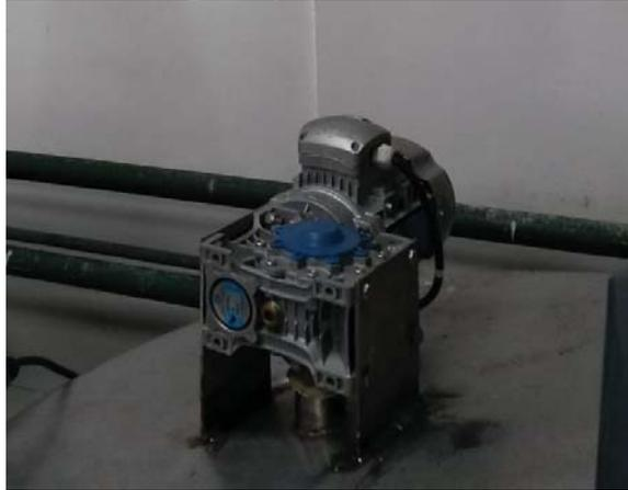
Figura 16. Motorreductor para tanques jarabe final
