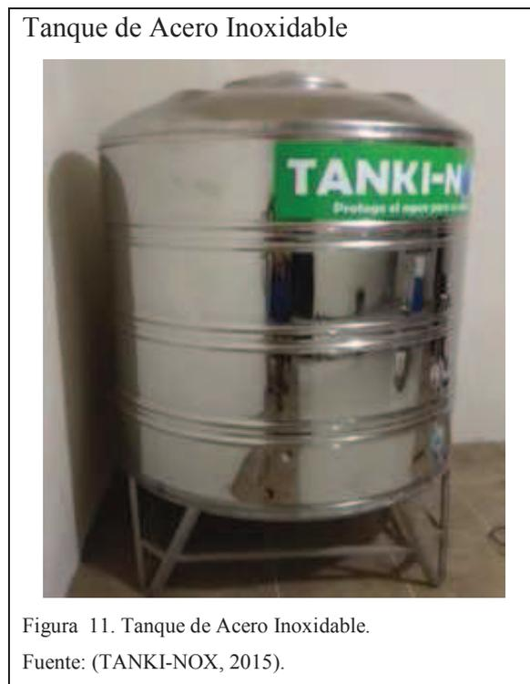
La principal características del tanque es que puede almacenar un volumen de 1500 litros en total. Al tanque se le incorpora una bomba para recircular externamente el plaguicida que se fermenta dentro de él.
