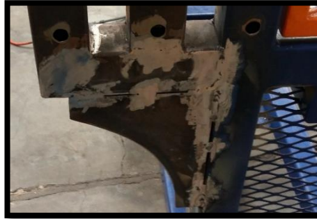
Fig 55: Soporte de estructura saliente
