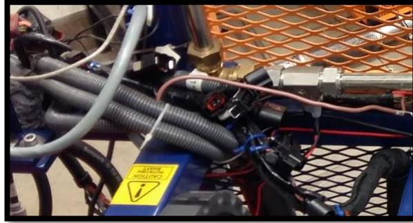
Fig 31: Cableado y elementos eléctricos en su posición original
