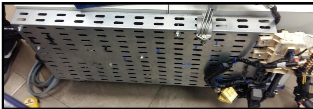
Fig 95: Unión de la plancha metálica con el gabinete electrónica
