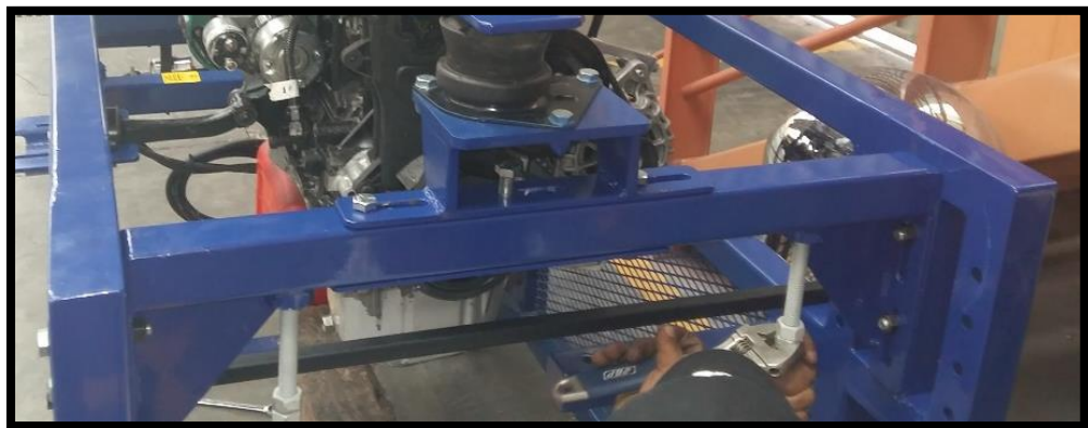
Fig 90: Centrado del motor con ayuda de regla metálica Fuente: Autores
