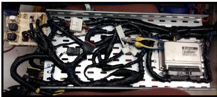
Fig 94: Alojamiento del cableado y elementos eléctrico en la plancha metálica
