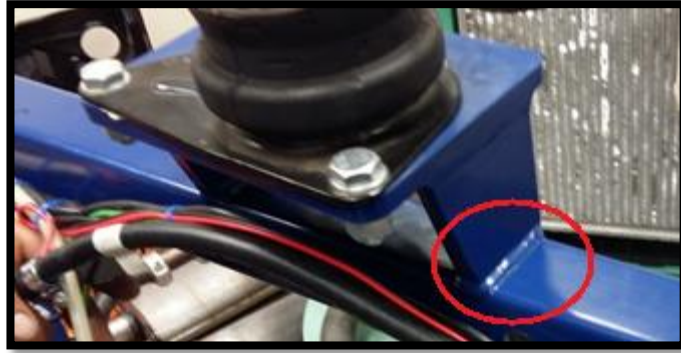
Fig 62: Base metálica retirada de la estructura original
