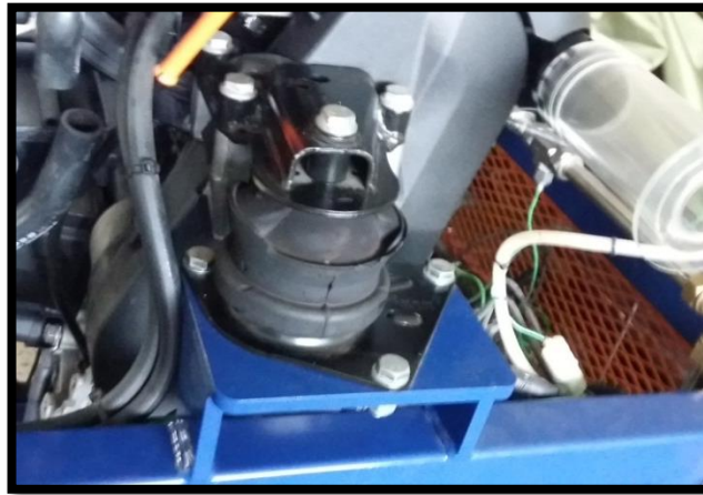
Fig. 10: Estructura de soporte 1
