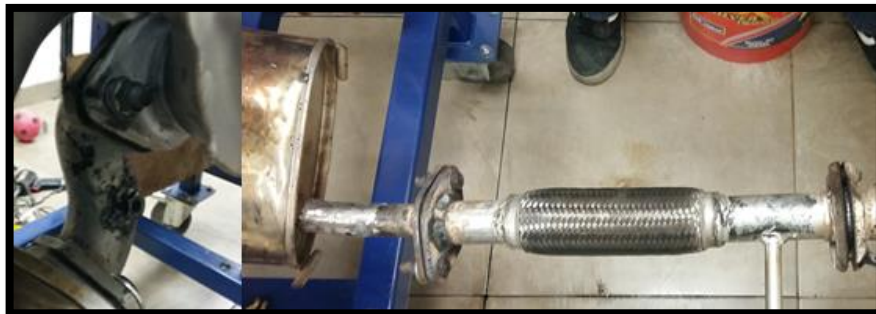
Fig 92: Unión del sistema de escape
