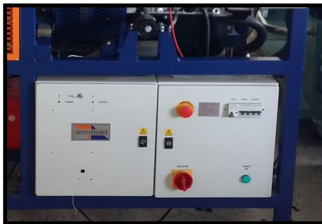
Fig 33: Gabinete electrónico y eléctrico sujeto a la estructura original del Banco Dinamométrico Fuente: Autores
