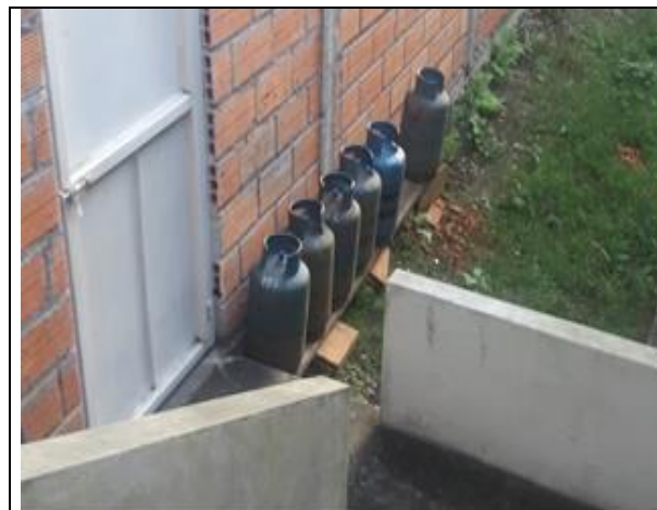
Ilustración 23. Riesgo de un incendio.
