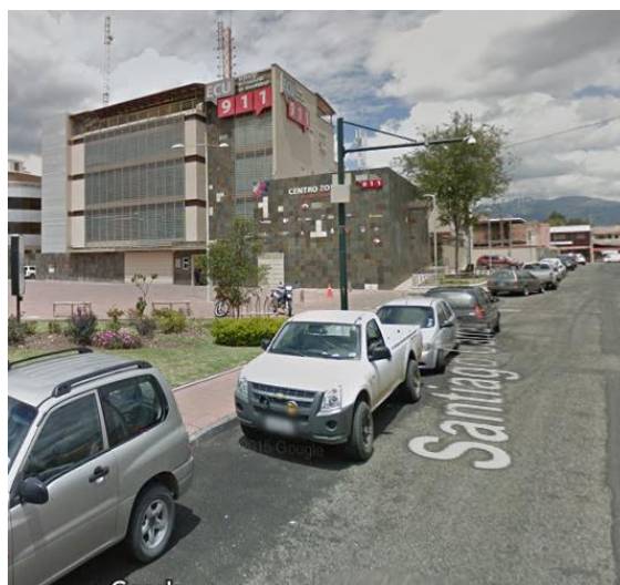
Figura 3.25 Ubicación del punto de Instalación[24]
