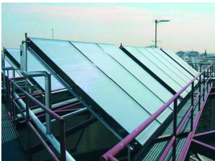
*Figura 13. Sistema solar térmico. (Fenercom 2007)*
