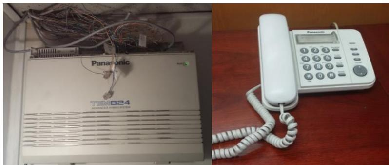
Figura 8. Central Telefónica Analógica y teléfonos empresa RACOMDES S.A.
