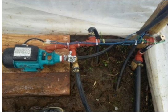
Figura 63. Instalación de la bomba de agua de 1/2hp Elaborado por: Jaime Chafra, Diego Monta
