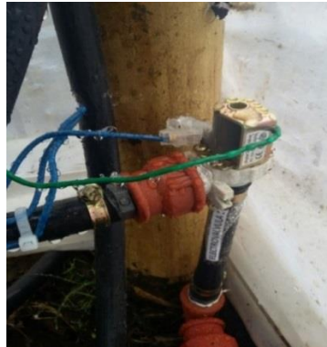
Figura 64. Instalación de la electroválvula de 110V AC Elaborado por: Jaime Chafra, Diego Monta
