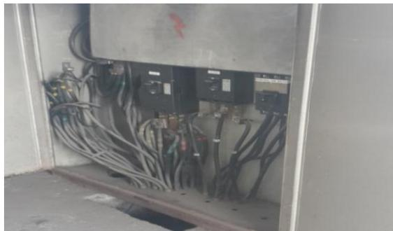
Figura 11. El tablero principal de la línea Crown se encuentra en los exteriores del área de producción. Elaborado por: Andrés Calero, Karla Correa.
