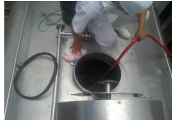
2.- Aplicación de solución desengrasante
