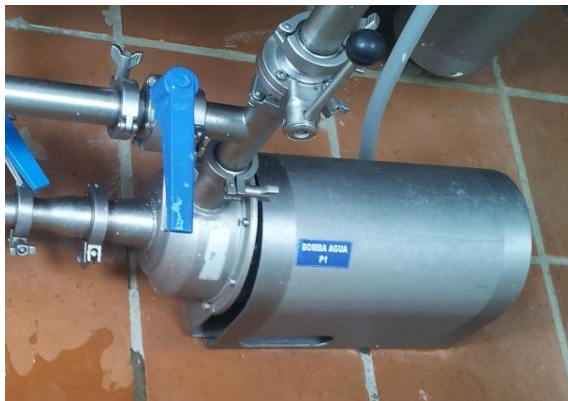
Figura 1.16 Bomba de leche Mecatec.
