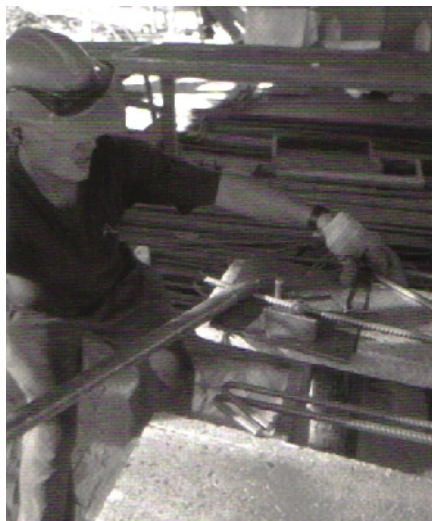
Figura 2.1. Doblado manual de barras
