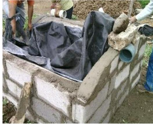
Ilustración: Enlucido de la base del biodigestor e instalación del codo de 4" x 45°, para acoplar a la entrada de la geomembrana.
