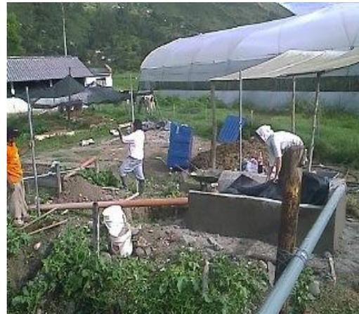
Ilustración: Base de concreto concluido; prueba de la geomembrana nueva e inicio de la estructura exterior
