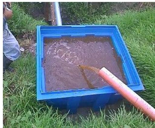
Ilustración: Captación del efluente y almacenamiento en el tanque de carga
