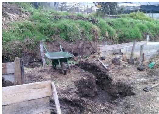
Ilustración: Encofrado y excavado del tanque de descarga
