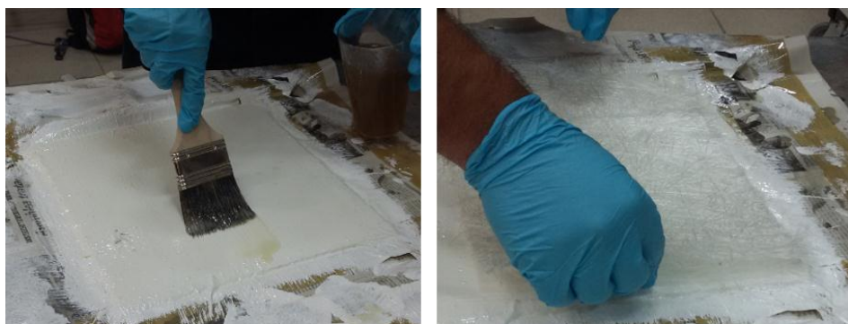
Figura 5. 17: Colocación de la Primera Capa de Resina Poliéster y Fibra de Vidrio.
