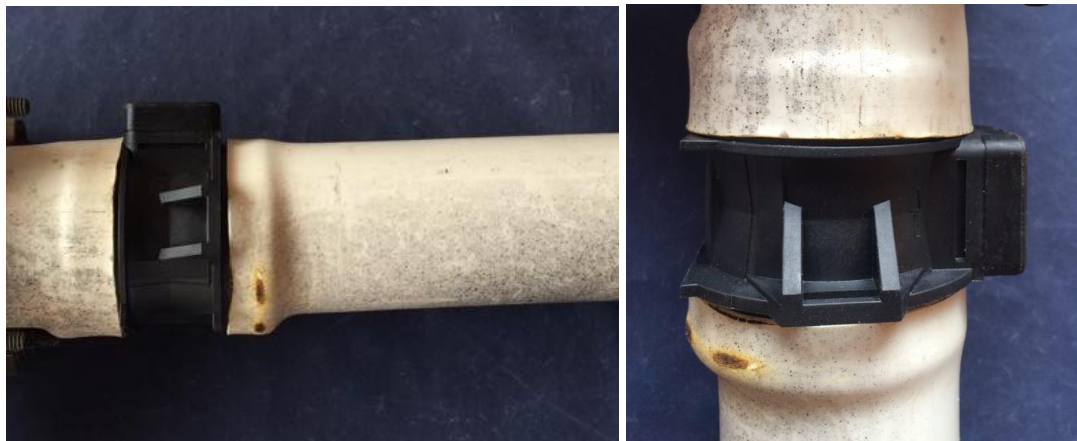
Figura 22: Acople entre el Sensor y los Tubos de Aspiración. Fuente: El Autor.
