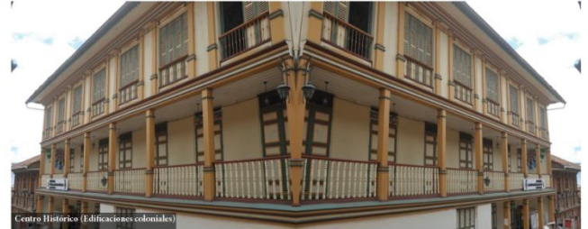
Centro Histórico (Edificaciones coloniales)
