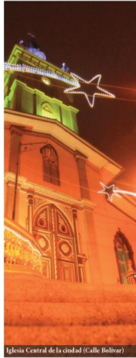
Iglesia Central de la ciudad (Calle Bolívar)
