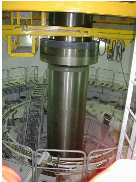
Figura 4. Eje o Acople Turbina- Generador
