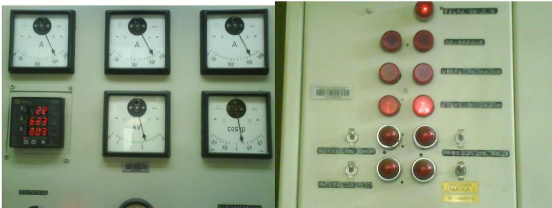
Figura 31. Paneles de medición y alarmas tableros de control (fotos propias en sitio)
