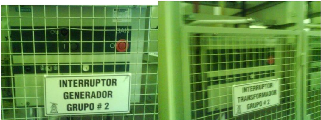
Figura 32. Interruptores del generador y transformador del grupo 2 (fotos propias en sitio)
