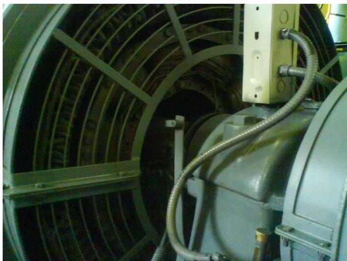
Figura 7. Rotor del generador (fotos propias en el sitio).
