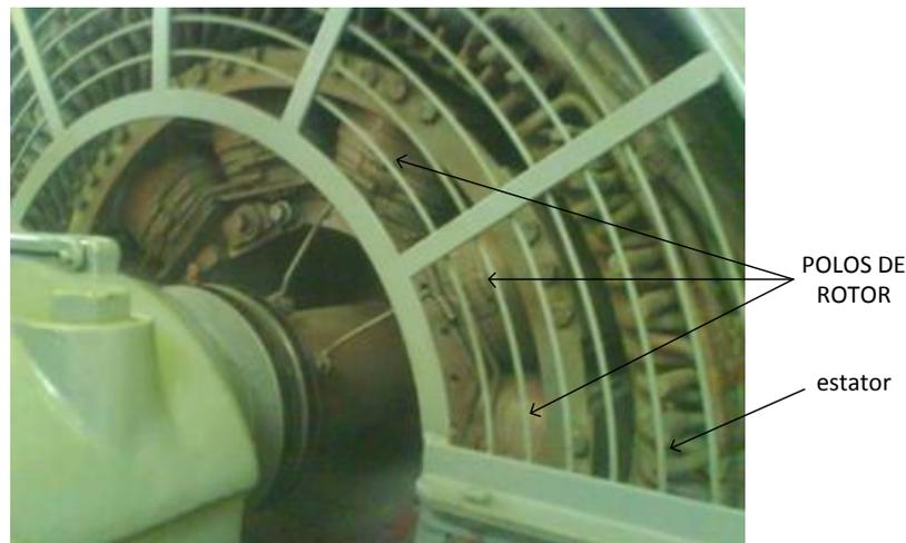
Figura 8. Vista de polos del rotor (fotos propias en el sitio).
