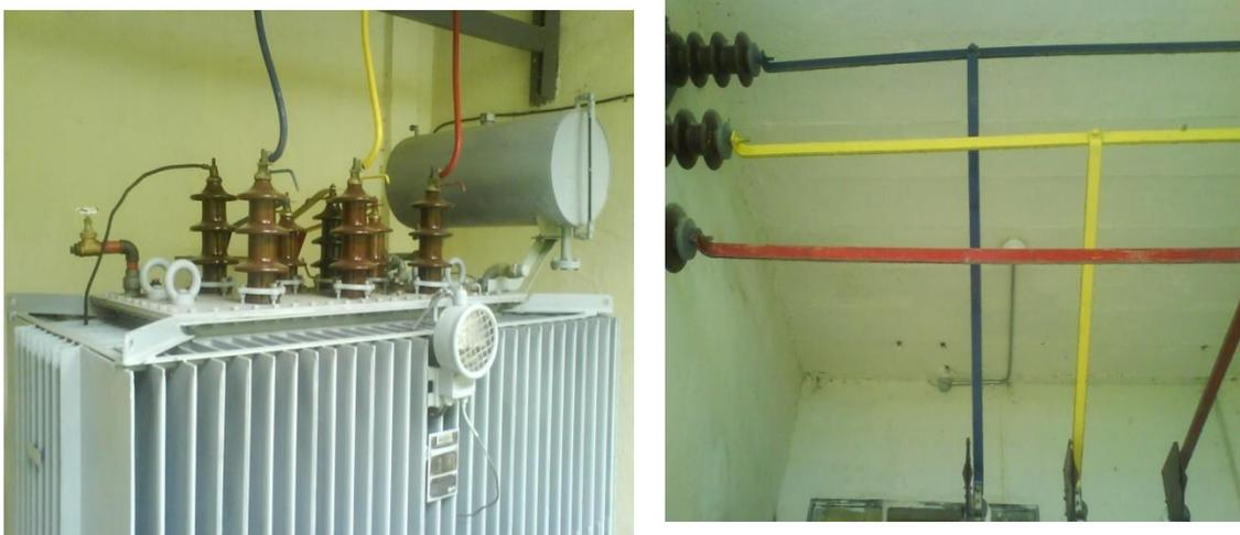
Figura 34. Transformador, barras de conexión y sistema enfriamiento grupo 2 (fotos propias en sitio)
