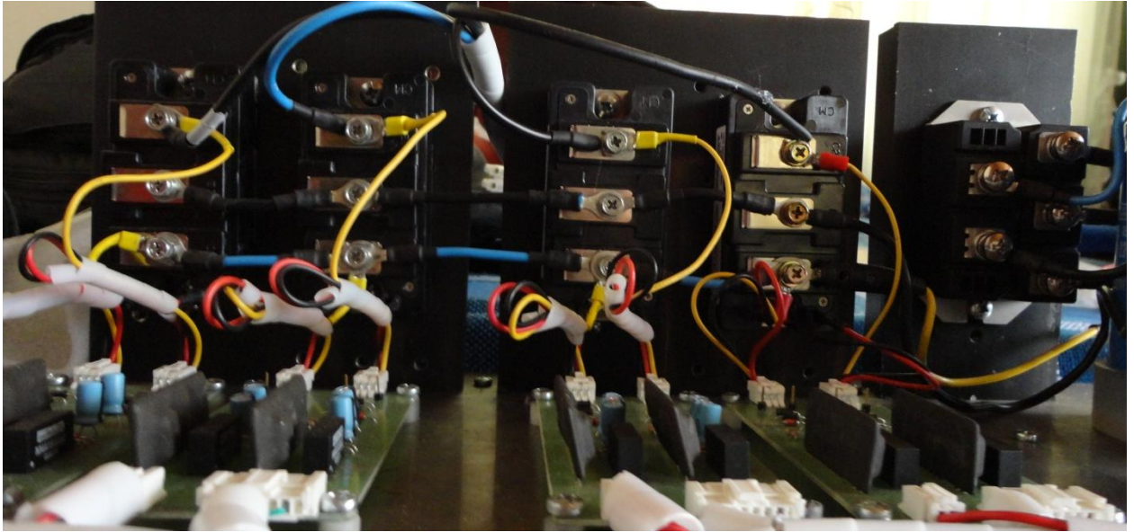
Fig.1.36 Inversor tetrafasico implementado.
