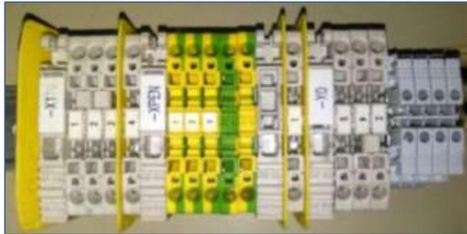
Figura 28 .Borneras de conexión.
