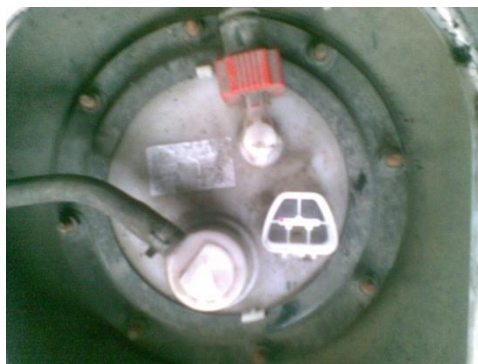
Fig. 1- 17 Conector macho sobre el tanque de combustible
