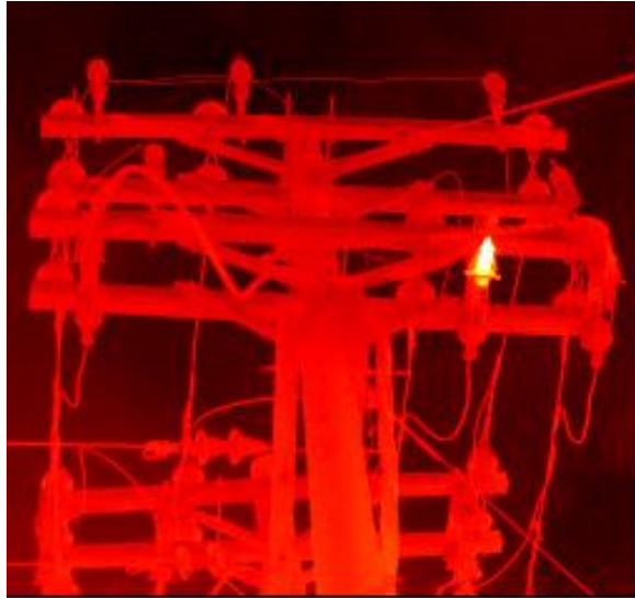
Fig. # 7 Inspección aérea.
