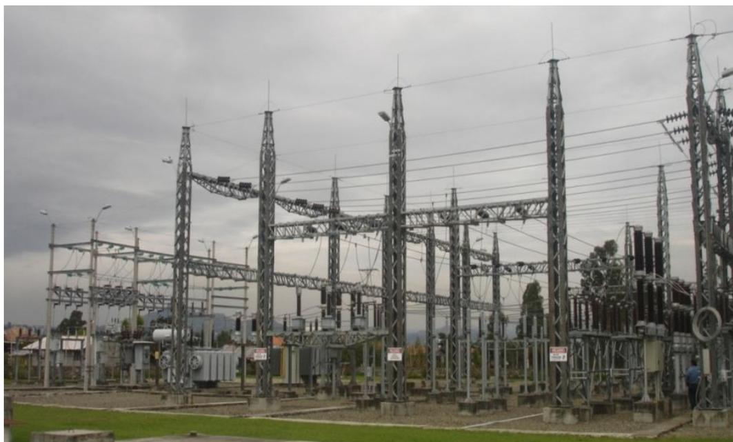
Figura 3.18 (SE07 – Ricaurte). Potencia instalada: 10/12.5 MVA, Nivel de tensión 69/22 kV.
