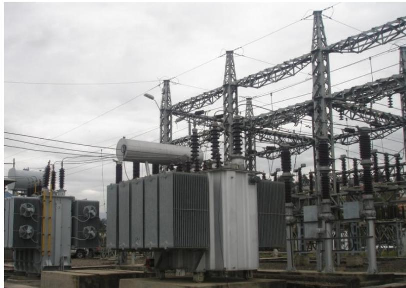
Figura 3.4 Dos unidades transformadoras, de izquierda a derecha: 24/32 MVA, OA/FA; 10/12,5 MVA OA/ FA, respectivamente.
