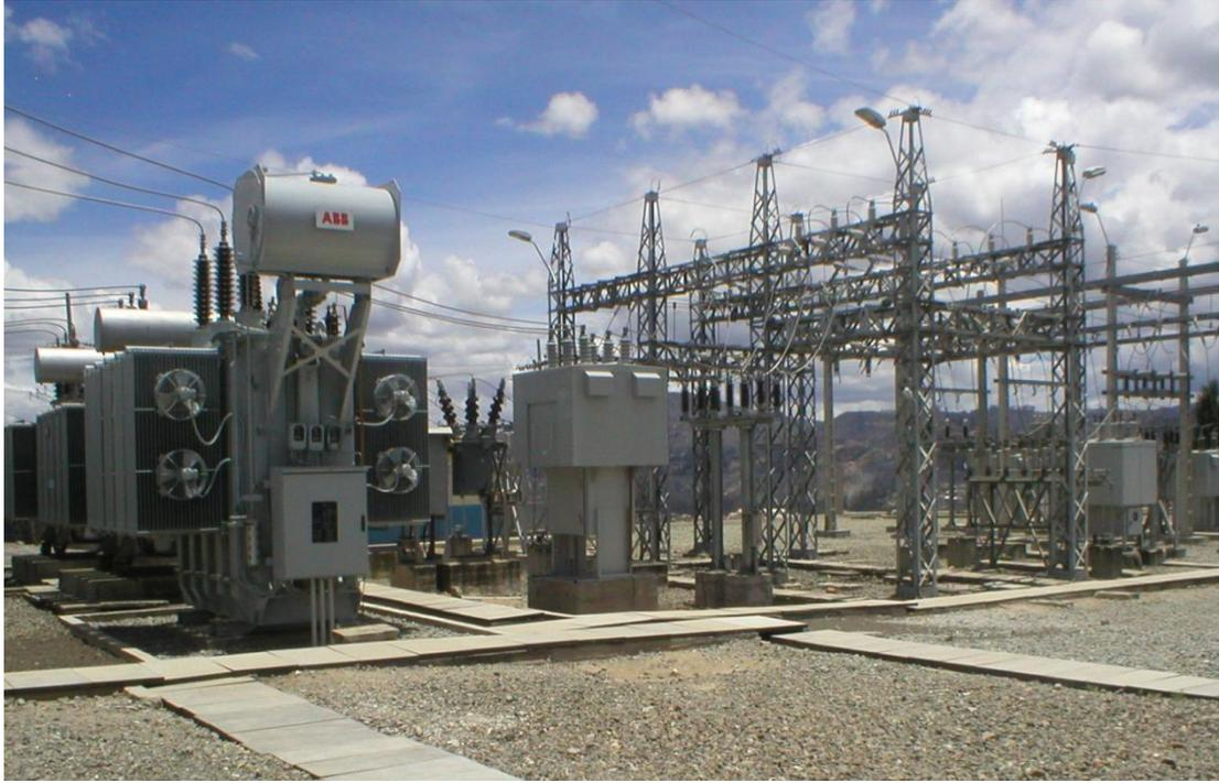
Figura 1. 2 Transformador de potencia de tres fases, 24/32 MVA, OA/FA, 69/22 kV.
