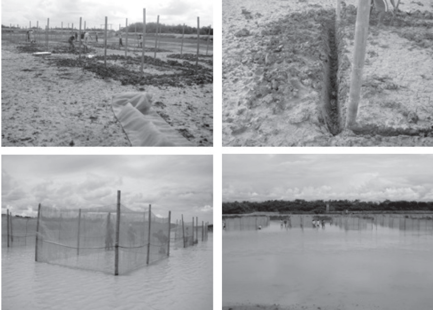
Figura 2 Construcción e instalación de unidades experimentales
