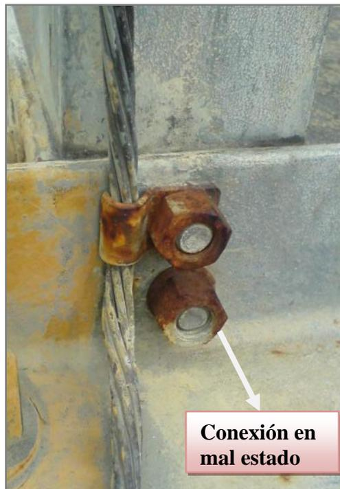
**Figura 18. Conexión del conductor de protección en mal estado (Fuente: Autor).**
