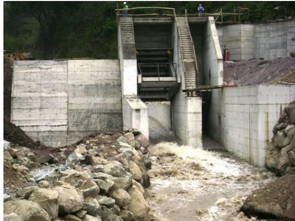
Figura No.2.7 Azud de Derivación. 10
