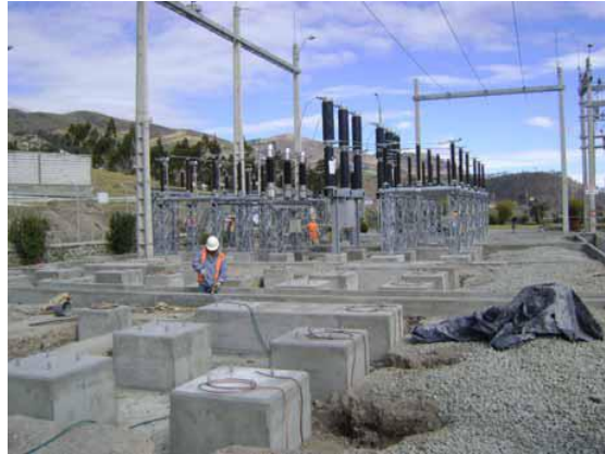
Figura No.2.17 Subestación Ocaña. 20
