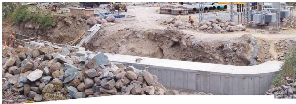
Figura No.2.15 Obras de Restitución. 18
