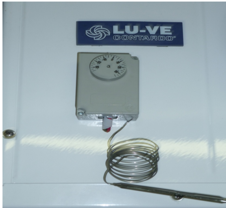
Foto: 17 Termómetro del frigorífico - planta de cárnicos UPS.
