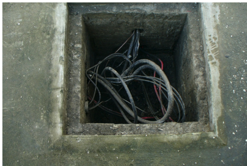
Figura 3.3 Canalización existente
