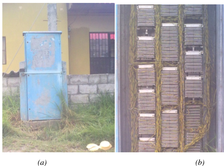
Figura 3.4 Armario de distribución distrito 22, (a) vista externa, (b) vista interna
