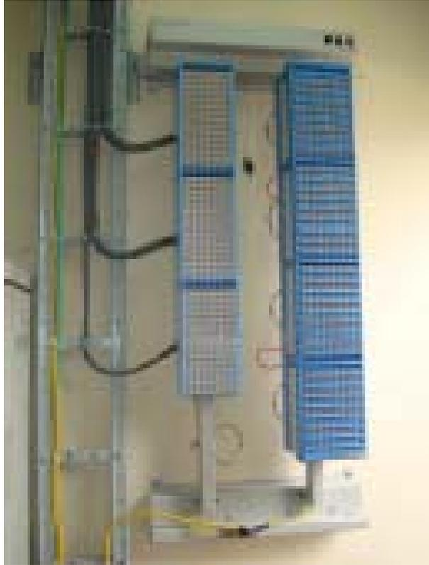
**Figura II-34. Regletas para distribución de red de cobre”<sup>6</sup>**
