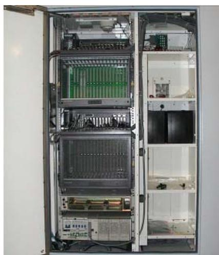
**Figura II-17. Presentación del Equipo UA5000 de Huawei”<sup>6</sup>**
