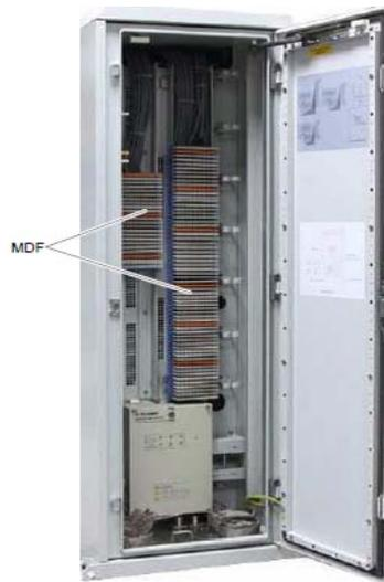
**Figura II-41. Apariencia del MDF usado en el compartimiento de distribución del cable del gabinete F01D1000 realizado”<sup>10</sup>**
