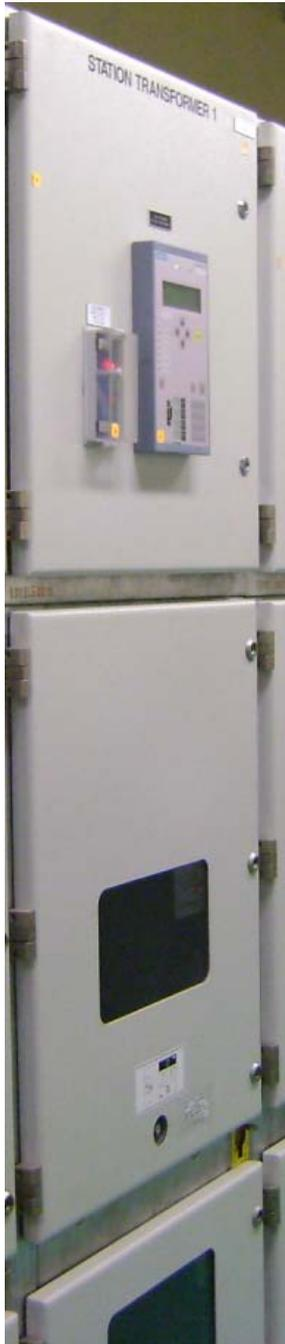
Sistema de control, aquí se encuentra todos los equipos de control que servirán para operar el disyuntor, así como todos los elementos de visualización. La celda como tal está conformada, por un relé de protección y uno de monitoreo, estando operativo únicamente de relé de control.
